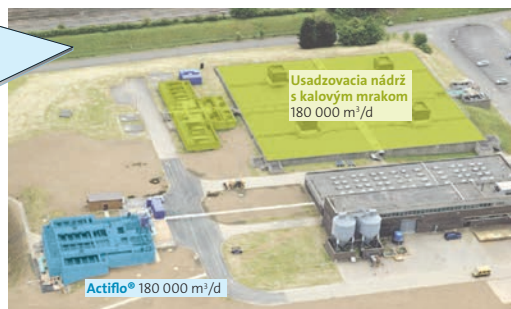
Pohľad na čistiareň odpadových vôd v Londýne – Heathrow (Veľká Británia). Čistenie, interozonácia a filtrácia granulovaným aktivovaným uhlíkom na produkciu pitnej vody.
